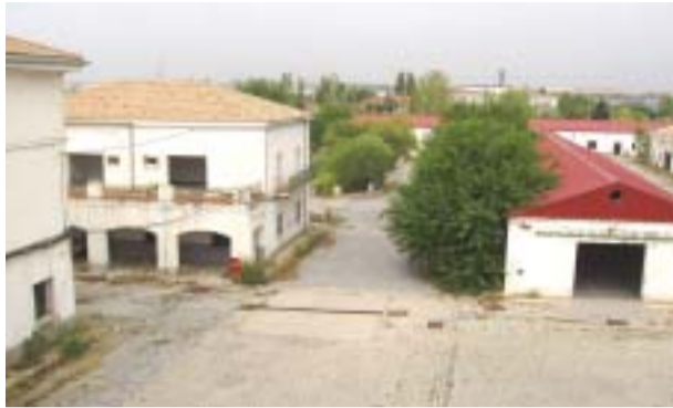
Naves y edificios interiores del mismo cuartel, listos para el derribo.
