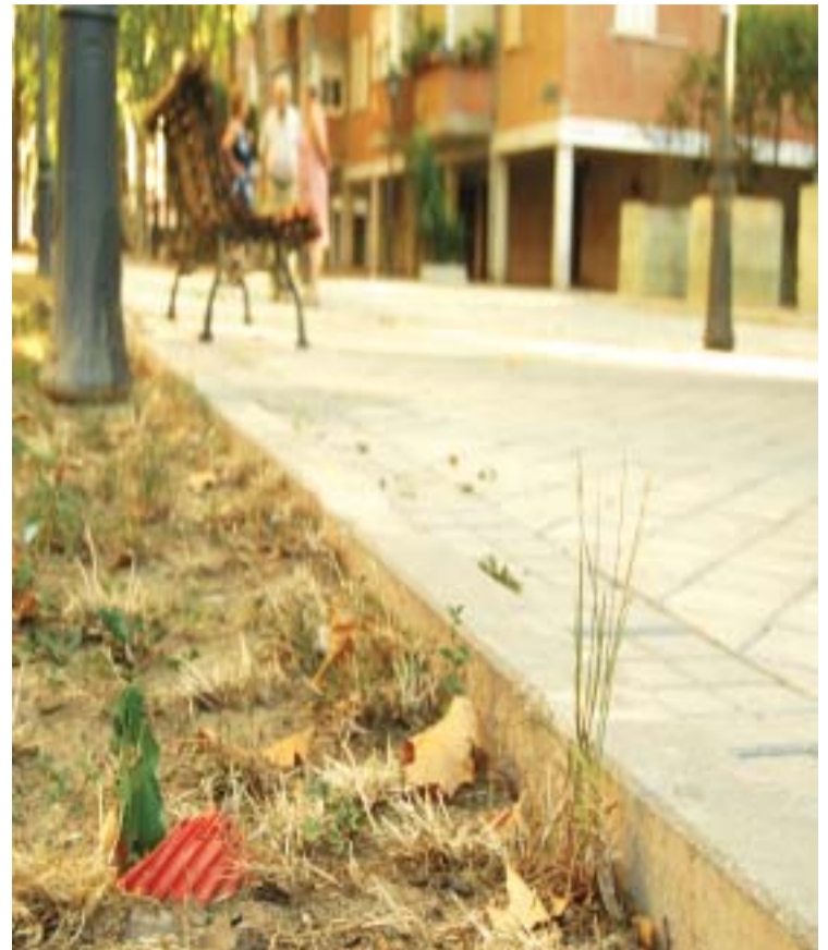
Lugar donde deberían estar instalados los riegos automáticos, rodeado de hierba seca y hojas. / J.M.M
